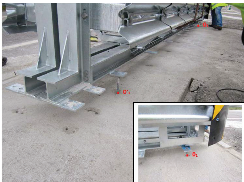
Colocação do atenuador de impacto.
