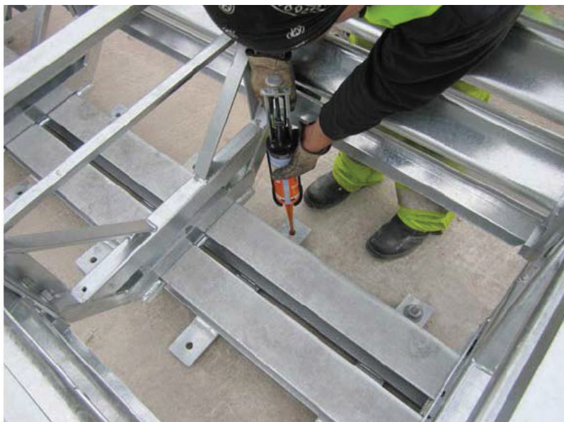
Aplicação da resina nas perfurações.
