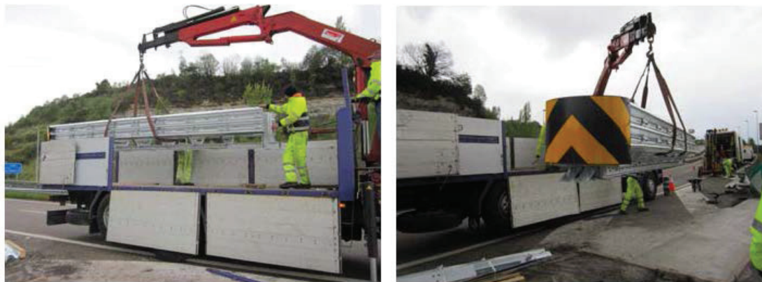
Descarga em obra de um atenuador de impacto AIR H110P.
