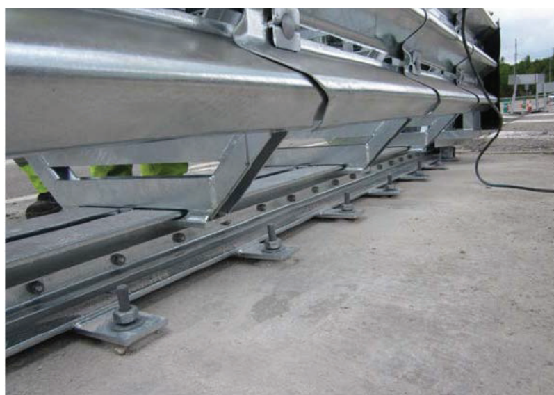
Parafusos de ancoragem antes do aperto das porcas.
