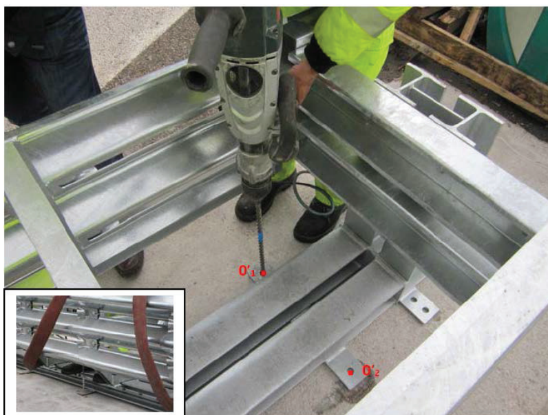
Posicionamento das placas de ancoragem correspondentes ao ponto O'_1 .
