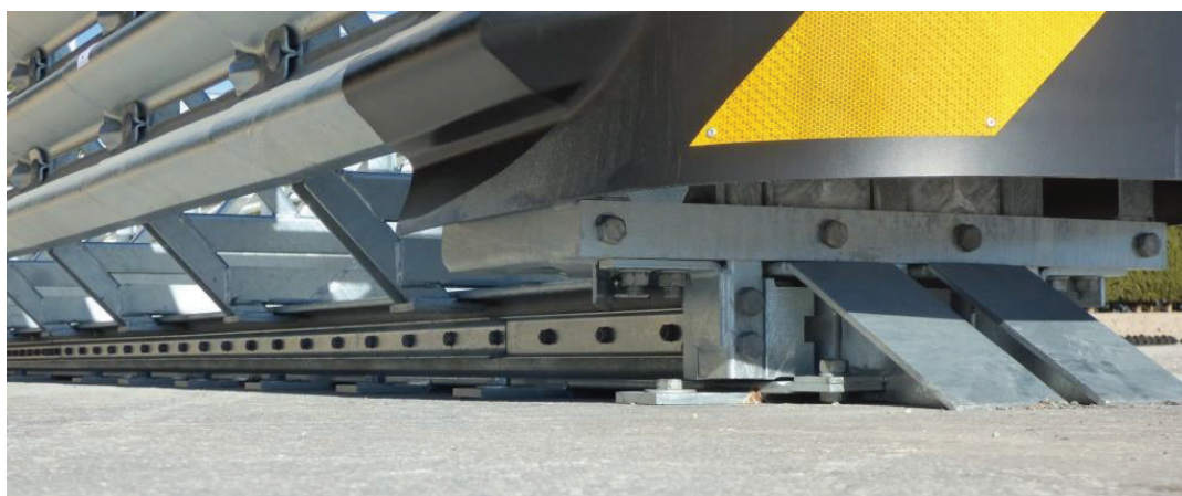
Atenuador fixado com parafusos de ancoragem TSM-A22x155 (abaixo das placas de ancoragem), parafuso M16x40 DIN933 e arruela M16 DIN9021
