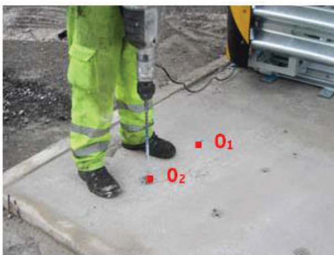
Remoção do atenuador de impacto e furação dos pontos de ancoragem O 1 e O 2 .
