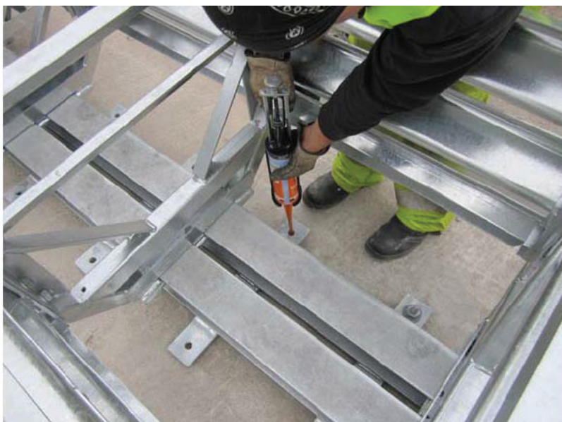
Aplicação da resina nas furações
