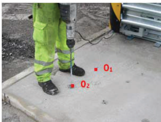
Remoção do atenuador de impacto e furação dos pontos de ancoragem O1, O2, O'1 e O'2
