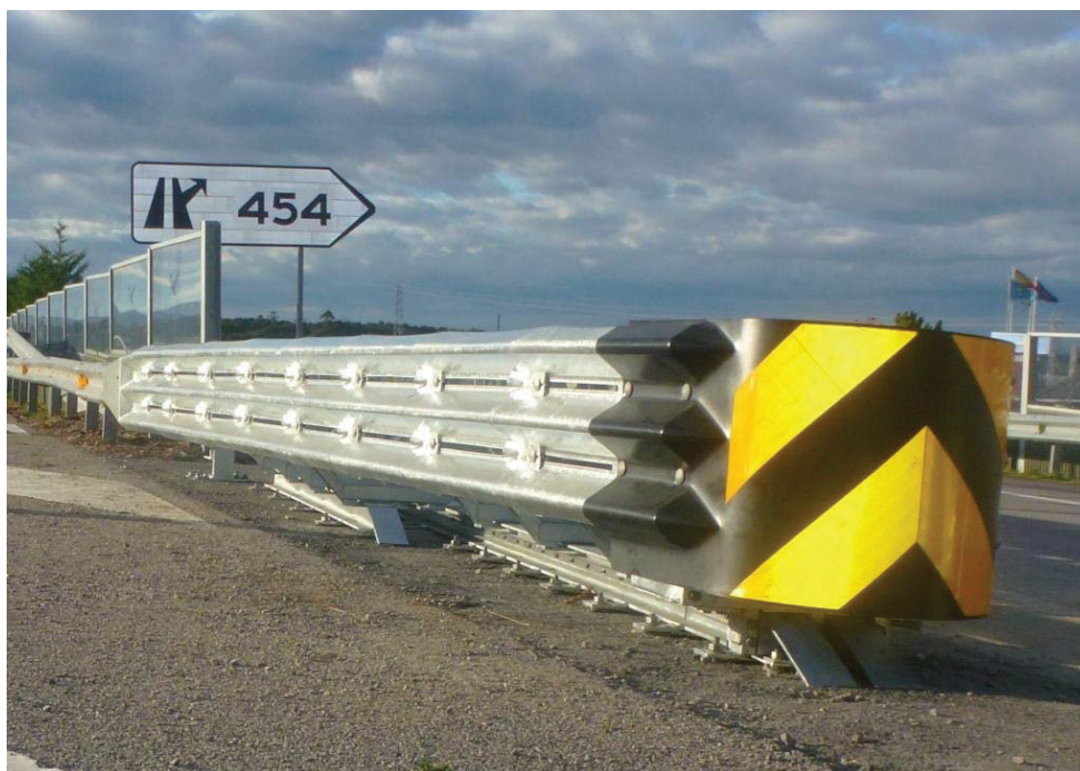
Atenuador AIR-H100V com os parafusos de ancoragem colocados
