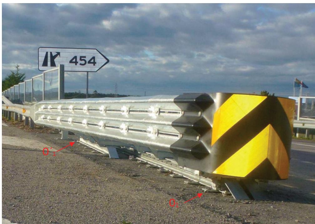
Posicionamento do atenuador de impacto para marcação dos pontos de ancoragem
