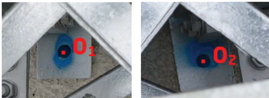
Marcação dos pontos de ancoragem O 1 e O 2
