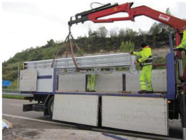
Descarga em obra de um atenuador de impacto AIR
